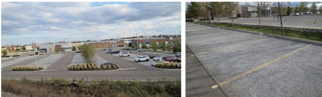
Figure 5. Cases de stationnement en asphalte poreux
