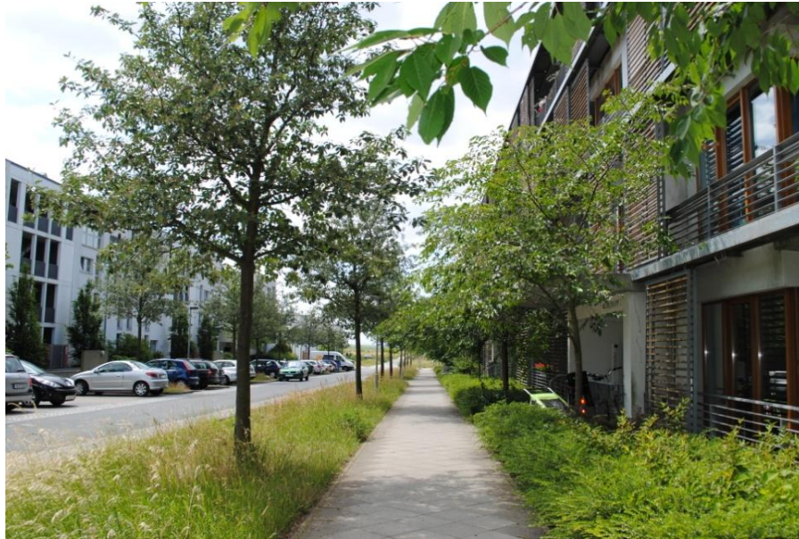
Figure 34 : Mulden Rigolen (noue), Kronsberg (Hanovre, Allemagne) Source : D. Dagenais
