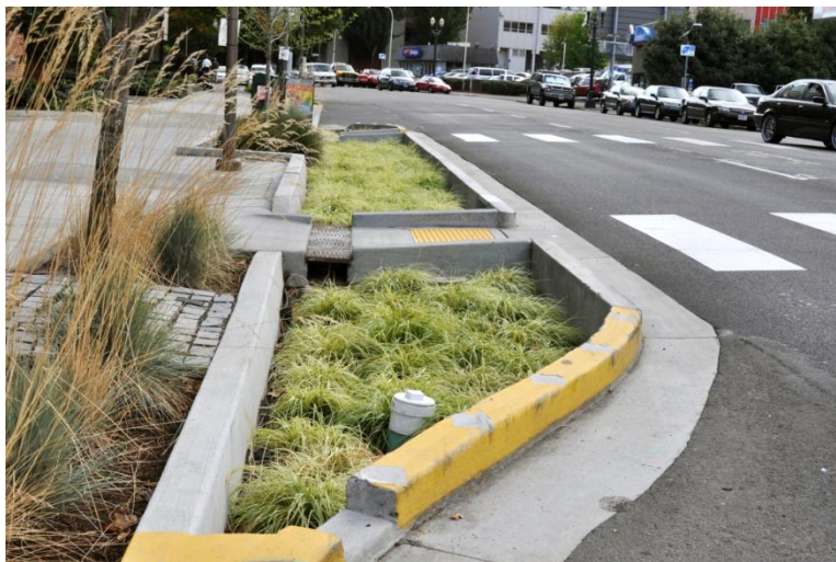
Figure 1 : Noue de biorétention (Portland, USA) Source : D. Dagenais
