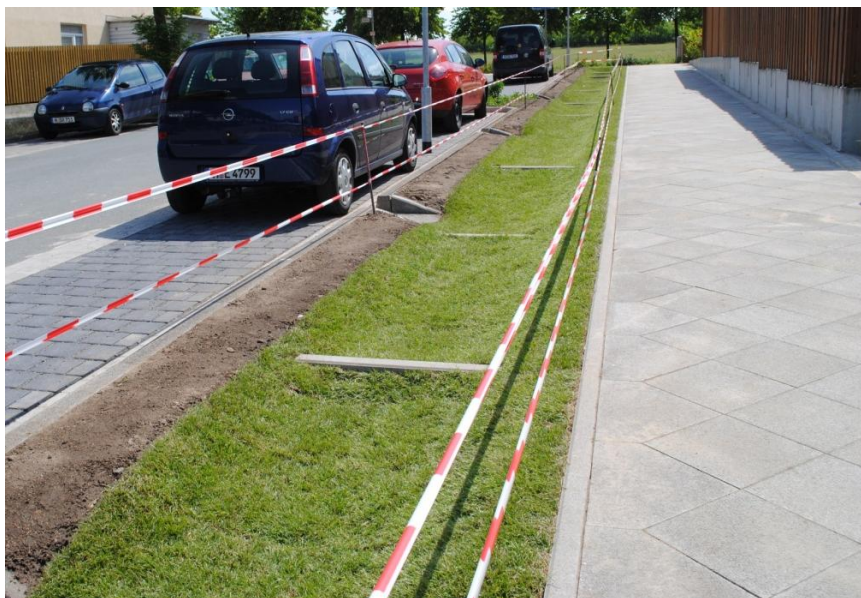
Figure 15 : Noue, Kronsberg, Allemagne.
