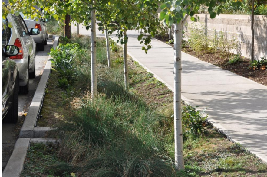
Figure 13 : Nœud de biorétention en bordure de rue, Portland, OR. Source : D.Dagenais
