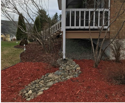
(a) Débranchement d'une gouttière vers un jardin de pluie à Sainte Florence. Le but est de diriger l'eau vers une surface imperméable plutôt que vers le réseau de drainage pluvial.
