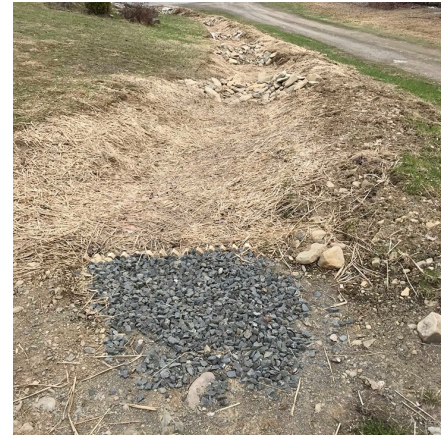
(d) Noie filtrante à Sainte Florence. Celle-ci consiste en un fossé assez peu prononcé dont les bords sont végétalisés. Les plantes limitent la vitesse de l'eau et l'érosion de l'aménagement.
