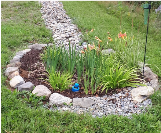
(c) Jardin de pluie et tranchée filtrante à Matapédia. Le jardin de pluie est une plate-bande perméable pouvant stocker les eaux de ruissellement puis les infiltrer à son rythme. La tranchée filtrante est composée de roches à découvert dont les interstices permettent le stockage de l'eau et son infiltration progressive.
