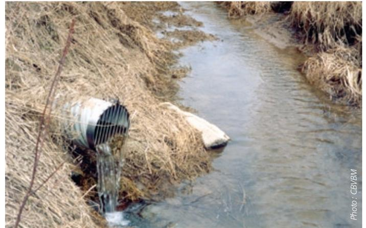
*Certaines terres agricoles retiennent trop l'eau. Des travaux de drainage sont alors effectués à l'aide de tuyaux perforés dans le sol. L'eau qui pénètre dans le sol lors de la fonte des neiges ou lors de fortes pluies est évacuée par les drains souterrains plus rapidement.*
