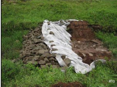
L'enrochement est déposé sur une membrane repliée sur la berme du côté amont.
