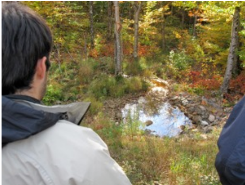
Aménagement d'un bassin de sédimentation par Enviroforêt à la Station Mont-Tremblant
