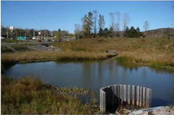
Écogénie œuvre dans la gestion des **eaux de pluie** et de **drainage**, par la caractérisation des milieux hydrauliques, l'élaboration de plans de gestion, la conception d'ouvrages tels que des **marais**, des **bassins de rétention** et de **sédimentation**, des **zones de bio-rétention**, de **jardins de pluie** et de tous les éléments permettant de répondre aux objectifs du *Guide québécois de la gestion des eaux pluviales*.
