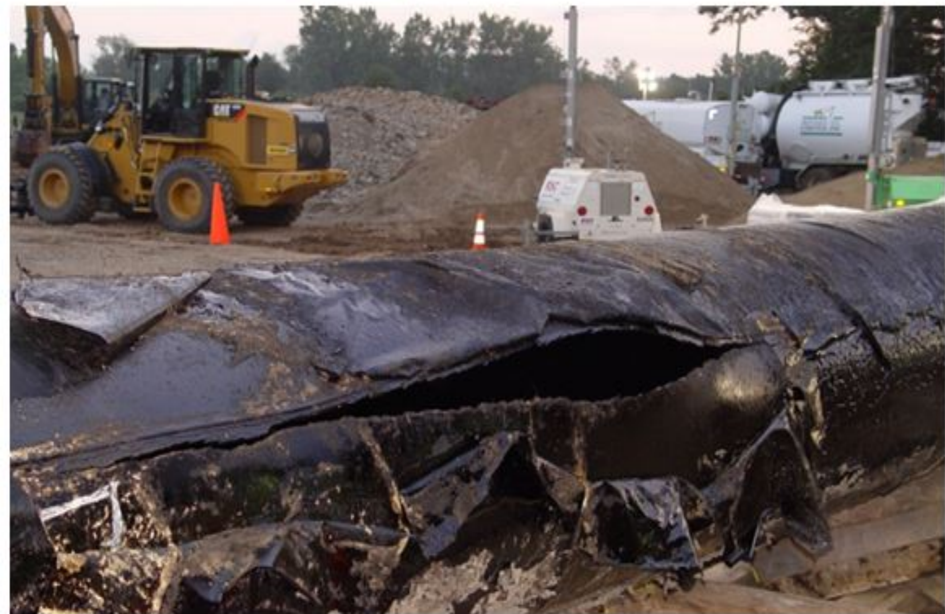
Photo : Fissure de l'Oléoduc Embridge 6B . Rivière Kalamazoo Michigan en 2010
