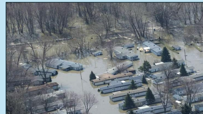
Rupture de la digue de Sainte-Marthe-sur-le-Lac Photothèque Le Soleil
