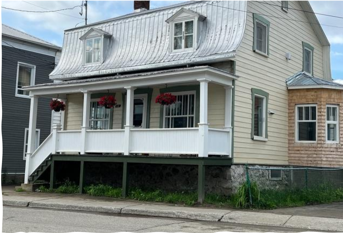
Bâtiment immunisé en 1960 Hauteur d'eau => 1m
