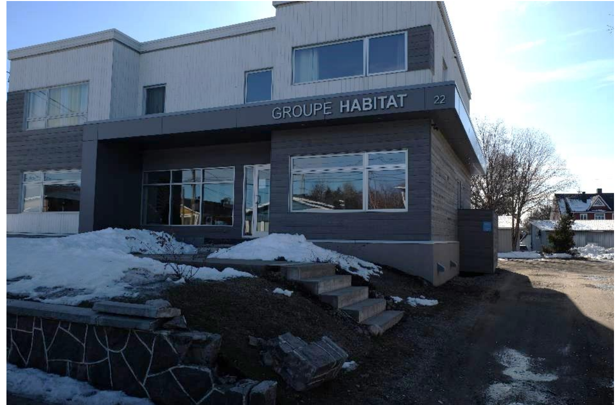
Bâtiment immunisé en 2013 Hauteur d'eau => 1m
